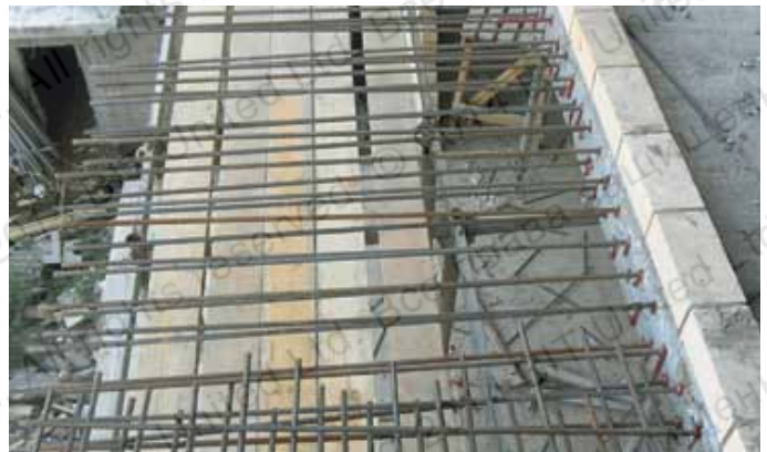
Наращивание железобетонных плит балконов и лоджий (исправление ошибок производства монолитных работ)
