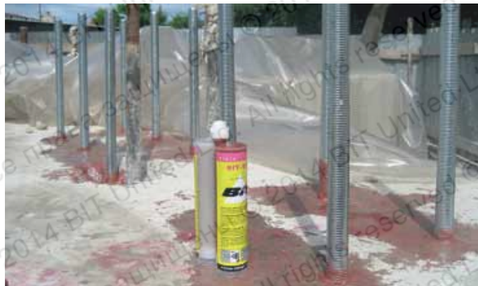
Крепление опорных конструкций башенного крана к фундаментной плите. Резьбовые шпильки M48. Глубина заделки 600 мм
