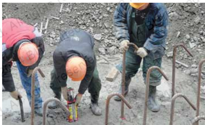
Устройство арматурных выпусков в существующей фундаментной плите (технологический регламент: очистка отверстий, инъектирование, установка арматурных стержней)
