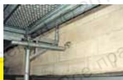
Единственно возможный способ надежного крепления строительных лесов к кладке из пустотелого керамического камня
