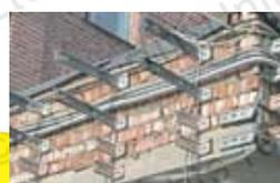
Крепление лифтового оборудования, кронштейнов направляющих и механизмов порталов к стенам лифтовых шахт, выполненных из кладочных материалов и пустотелого кирпича
