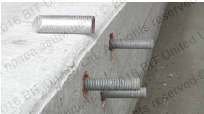
Установка анкер-гильз с внутренней резьбой в бетонный парапет (крепление съемных конструкций при необходимости планового демонтажа)
