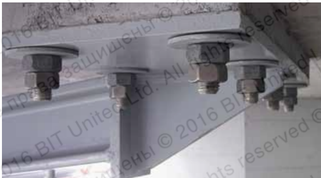
Крепление элементов металлических конструкций с помощью химических анкеров в растянутую зону бетона
