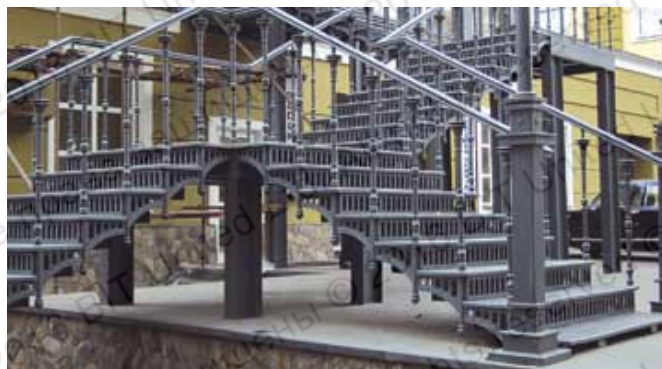
Крепление массивных литых элементов чугунных конструкций лестничного марша, выполненного по индивидуальному проекту (Музей техники Вадима Задорожного, Красногорский район Московской области, 2007 г.)
