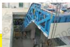
Монтаж несущей рамы постажного эскалятора к железобетонным плитам перекрытий торгового центра (г. Краснодар)
