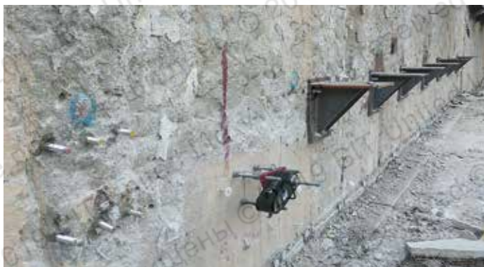
Установка опорных столиков для монтажа распорной системы ограждения котлована (Павелецкая площадь, г. Москва, 2018 г.)
