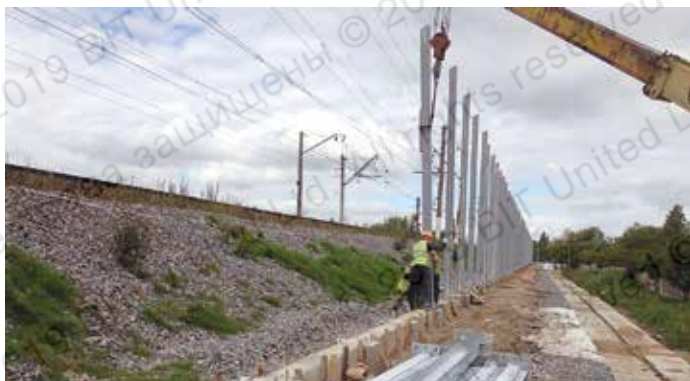
Монтаж металлических стоек шумозащитных экранов к железобетонному ростверку вдоль железнодорожных путей (г. Павловск, 2013 г.)
