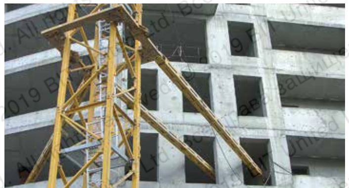
Крепление башенных кранов к перекрытиям и колоннам в высотном строительстве
